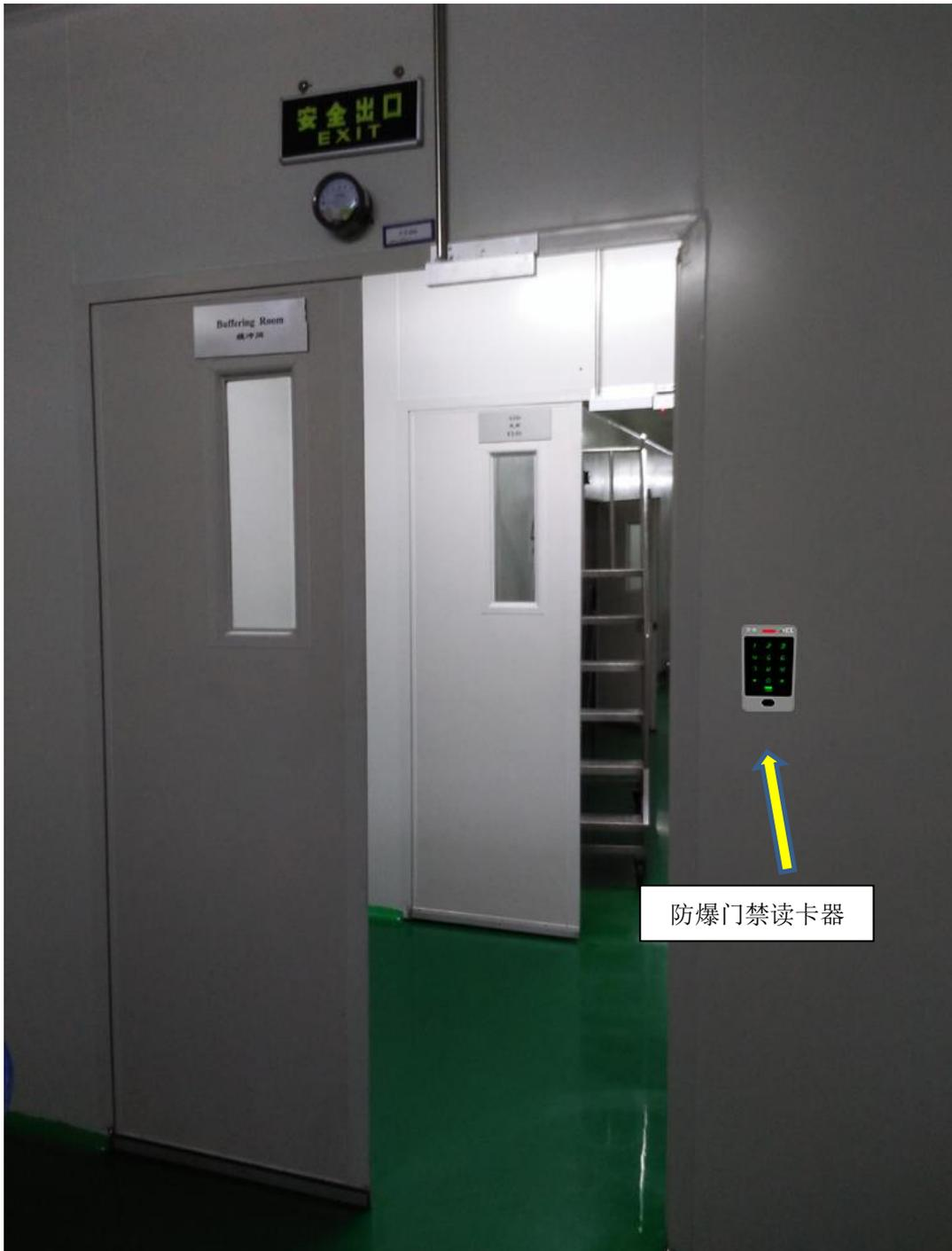
防爆门禁读卡器安装于门把手旁边墙体上，控制人员进出权限和人员进出记录，内外出门可安装防爆出门开关，如需要进出门都需要刷卡，内部也需要安装井田防爆读卡器。
